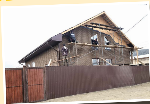
So verliefen die Bauarbeiten in Tuwa
